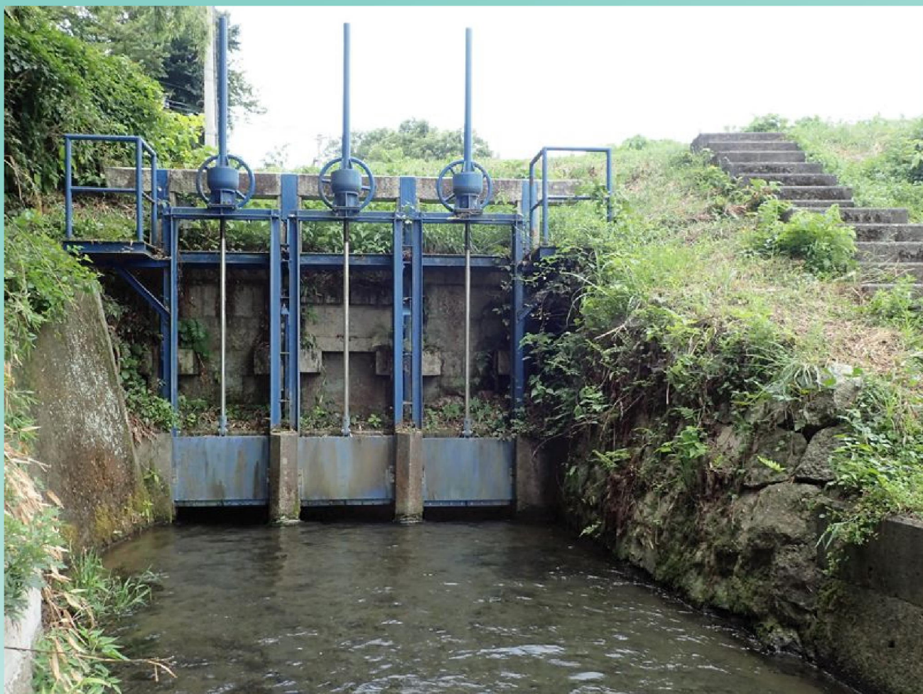
饗庭井取水口【明治38年3月竣工】
