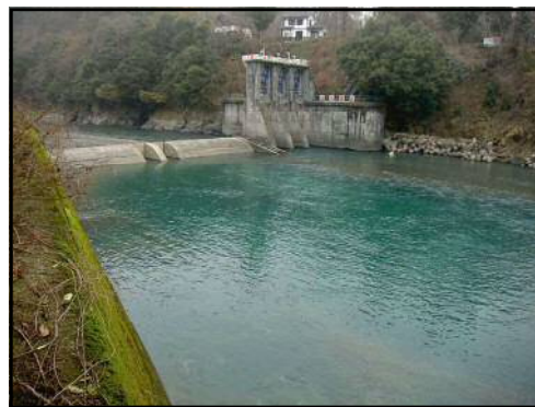
③ 工事完了
