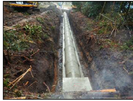
右岸幹線用水路 安曇川町田中地先 (田中神社前)
