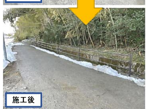
転落防止柵設置 L=58.4m
